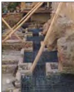
شکل ۹۰-۱ مهاربندی با شمع چوبی
