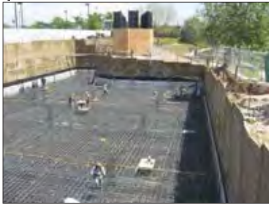
شکل ۱-۶۲ پی بتن مسلح یکپارچه (رادیه ژنرال)
