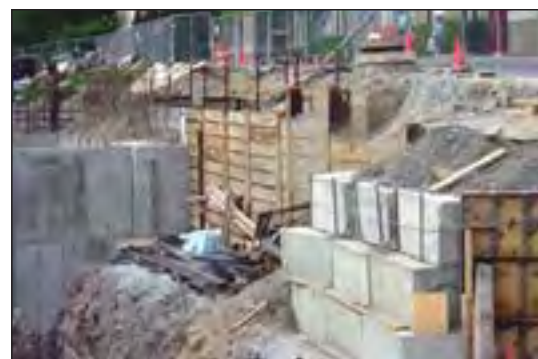
شکل ۹۱-۱ مهاربندی با دیوار مانع چوبی
