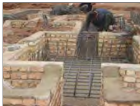
شکل ۱-۸۲ قالب‌بندی آجری در اطراف پی
