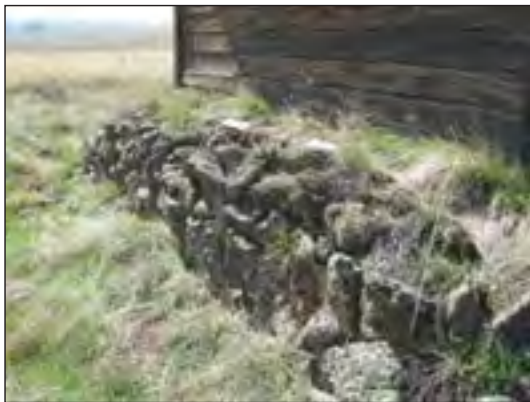
شکل ۱-۳۲ پی سنگی با سنگ لاشه
