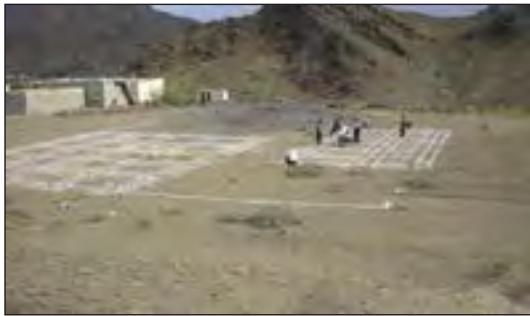
شکل ۱-۸۳ پیاده کردن نقشه روی زمین
