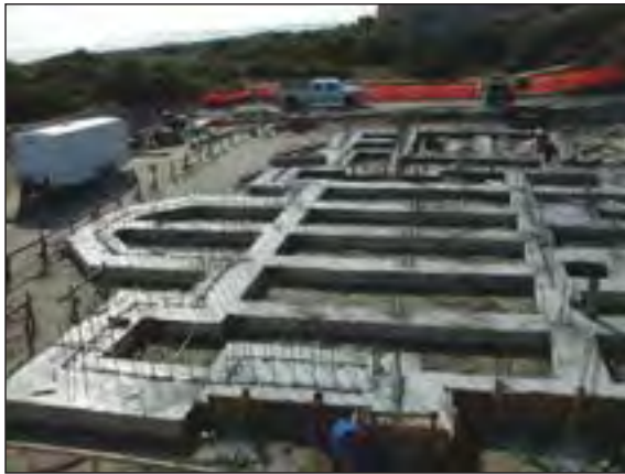
شکل ۱-۵۶ پی بتن مسلح نواری شبکه ای زیرستون
