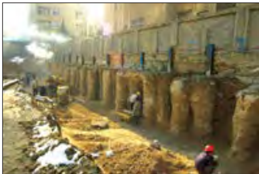
شکل ۸۸-۱ مهاربندی با پشت بند خاکی ستونی
