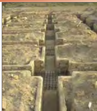
شکل ۴۸-۱ آرماتورگذاری پی تکی کلاف بندی شده
