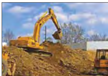
شکل ۱-۱۳- کندن زمین با وسایل مکانیکی
