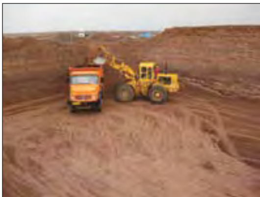
شکل ۱-۸۵ گودبرداری با لودر در زمین نامحدود
