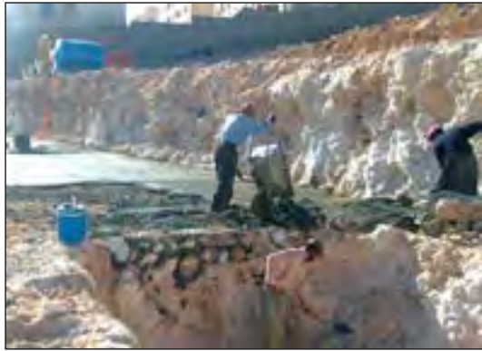
شکل ۸۷-۱ گودبرداری دستی (با بیل و کلنگ)
