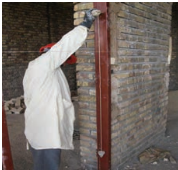
شکل ۳-۲۳: شاقول کردن وادار
