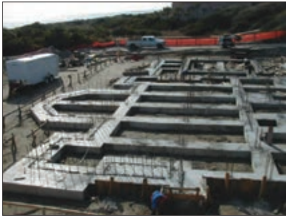
شکل ۳-۶۲ پی بتن مسلح نواری شبکه ای زیرستون
