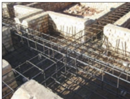
شکل ۳-۱۳۵ عبور میلگردهای شناژ در پی
