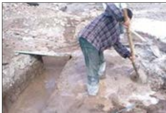
شکل ۳-۳۷ اجرای شفته آهک در فونداسیون
