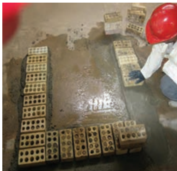
شکل ۱ - ۳۳ (ج): ریسمان کشی و چیدن ضلع سوم
