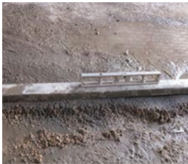
شکل ۱- ۶۹: تراز کردن روی ملات
