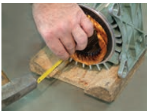
شکل ۲-۲۲ - بیرون آوردن گوه یا کاغذ برشمان از داخل شیارها
