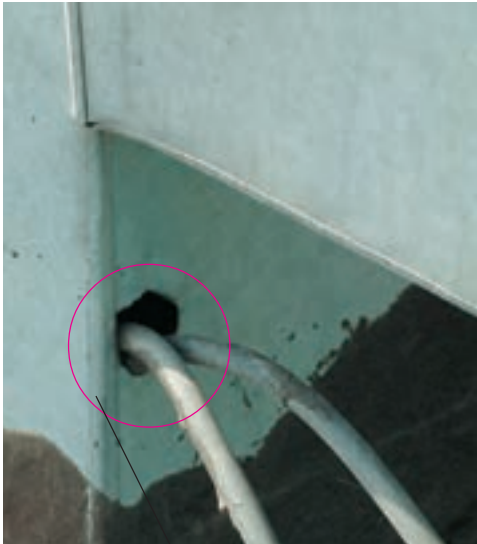
کابل‌کشی در داخل کانال کولر
