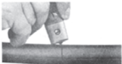
شکل ۲۷-۵- عایق برداری
