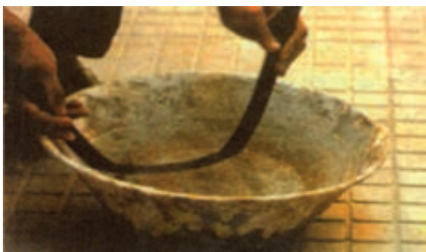
شکل ۴-۴۵ - سرد کردن لوله پس از خم‌کاری
