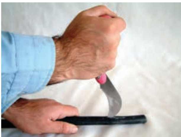
شکل ۳۲-۵- روکش برداری غلط
