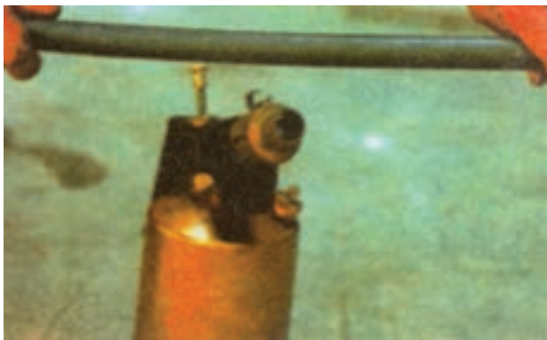
شکل ۴-۴۳ - حرارت دادن لوله‌ی PVC
