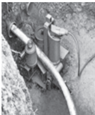
شکل ۵-۵۱- دستگاه کشش کابل
