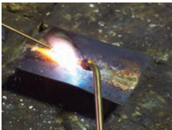
شکل ۴-۷- ایجاد گاز در اطراف محل لحیم کاری
