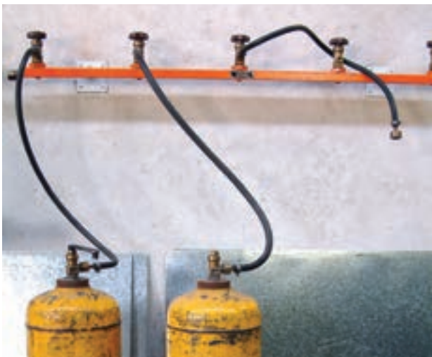
شکل ۲۵-۲- گاز استیلین از کپسول به خط لوله‌ی گاز هدایت می‌شود.
