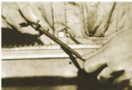
شکل ۱۴-۲۲- تیزکردن اره با استفاده از سوهان.
