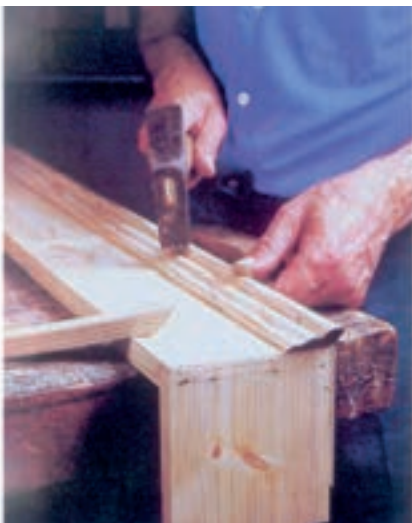
شکل ۱۳-۱۰- نصب زهوار با میخ.
