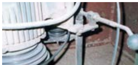
شکل ۳-۱۴- باز کردن درپوش (روی تسمه‌ها).
