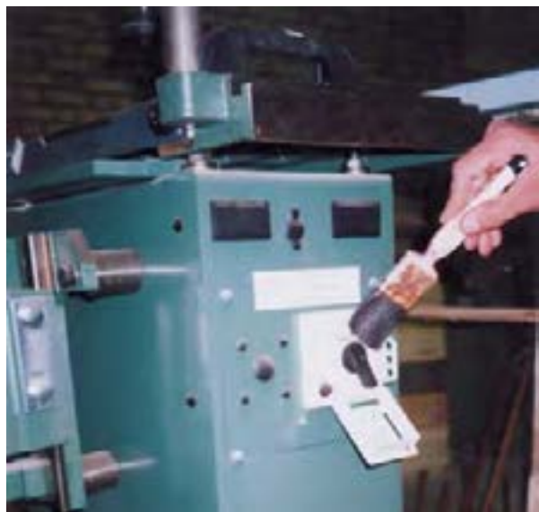
شکل ۱۰-۱۵- گردگیری و تمیز کردن کلید برق.
