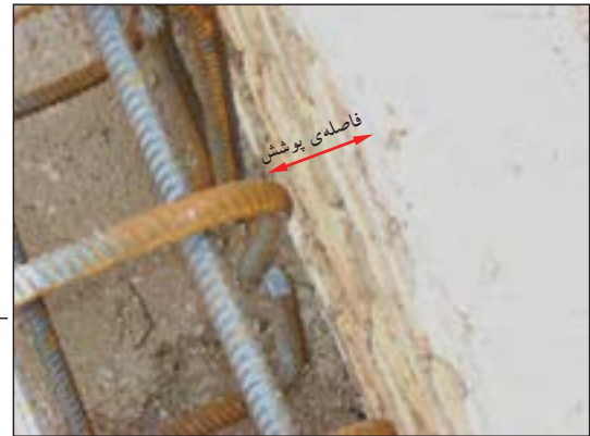
شکل ۲-۱۲۶ فاصله‌ی پوشش و قلاب سر میل‌گردها
