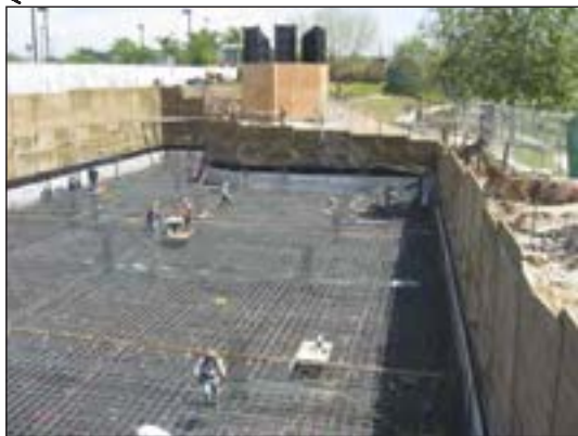
شکل ۱-۶۲ پی بتن مسلح یکپارچه (رادیه ژنرال)
