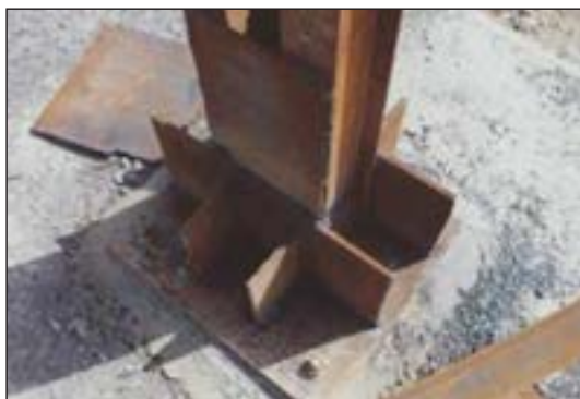
شکل ۱۶۸-۲ اتصال گیردار
