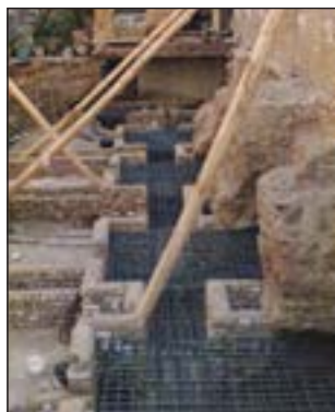
شکل ۹۰-۱ مهاربندی با شمع چوبی
