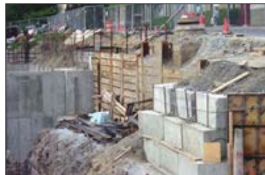
شکل ۹۱-۱ مهاربندی با دیوار مانع چوبی
