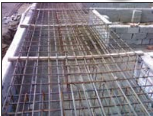
شکل ۱۴۶-۲ پی نواری و آرماتورگذاری آن
