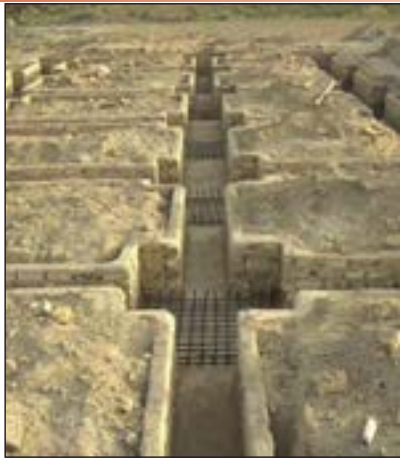
شکل ۴۸-۱ آرماتورگذاری پی تکی کلاف بندی شده
