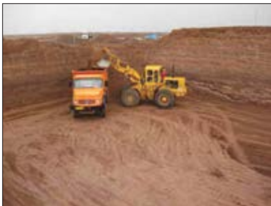
شکل ۱-۸۵ گودبرداری با لودر در زمین نامحدود
