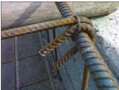
شکل ۲-۱۴۲ قلاب سر خاموت و بستن آن با مفتول
