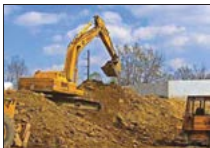
شکل ۱-۱۳- کندن زمین با وسایل مکانیکی
