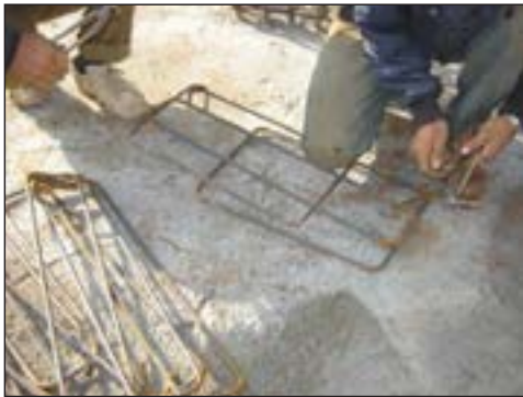
شکل ۲-۱۴۰ خم آرماتور و ساخت خاموت
