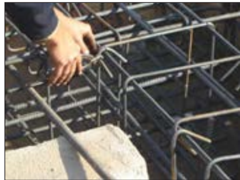
شکل ۲-۱۴۱ بستن خاموت دور آرماتور اصلی شناژ
