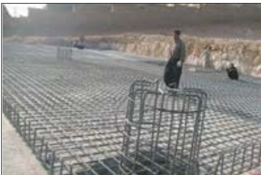
شکل ۱۵۲-۲ آرماتورگذاری پی صفحه‌ای با ستون‌های بتنی
