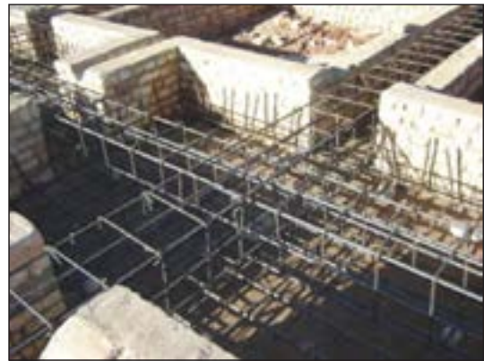
شکل ۷۱-۲ عبور میلگردهای شناژ در پی
