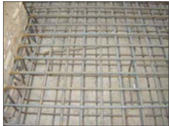
شکل ۱۴۷-۲ پی نواری و آرماتورگذاری آن
