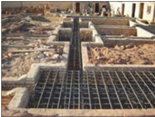
شکل ۷۰-۲ میلگردگذاری در پی کلاف بندی
