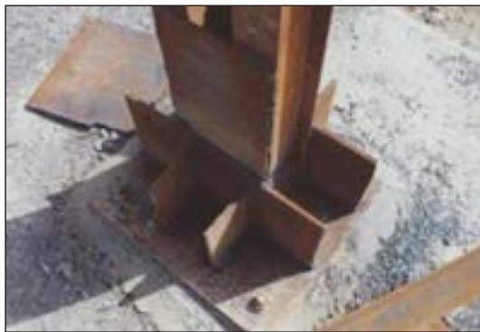
شکل ۱۶۸-۲ اتصال گیردار
