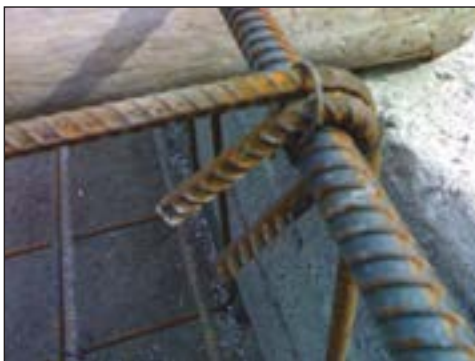
شکل ۲-۱۴۲ قلاب سرخاموت و بستن آن با مفتول
