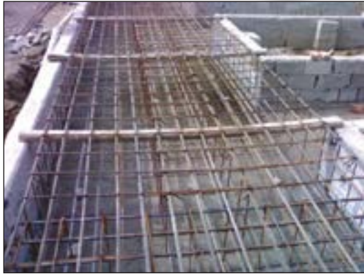
شکل ۱۴۶-۲ پی نواری و آرماتورگذاری آن
