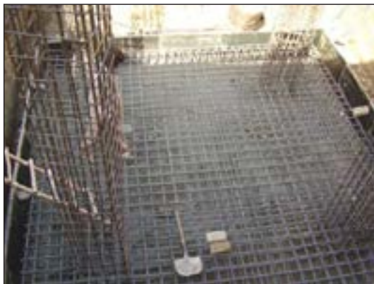
شکل ۱۵۱-۲ آرماتورگذاری پی صفحه‌ای با ستون‌های بتنی
