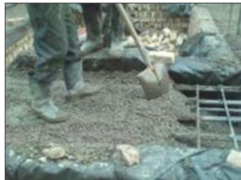
شکل ۲-۱۴۵ مرحله ی بتن ریزی داخل پی
