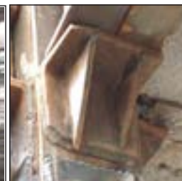
اتصال تیر به ستون به صورت لچکی
