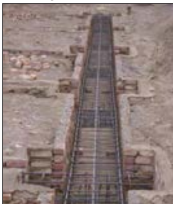
شکل ۷۲-۲ پی و شناژ قبل از بتن ریزی
