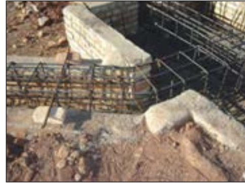
شکل ۲-۱۴۳ آرماتورهای شناژ و پی
