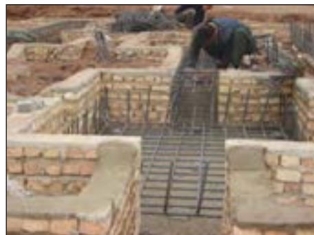
شکل ۱-۸۲ قالب‌بندی آجری در اطراف پی
