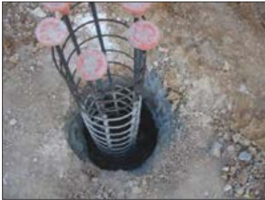
شکل ۱-۷۳ پی چاهی در حال اجرا
