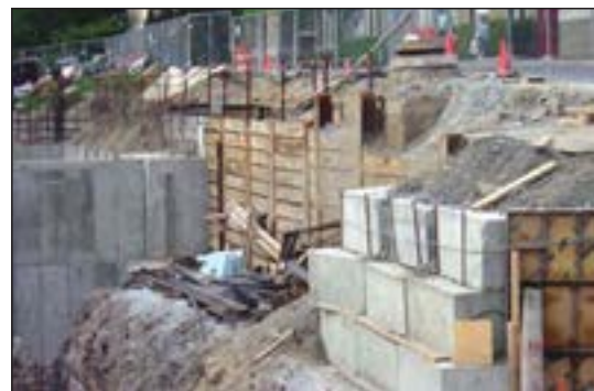
شکل ۹۱-۱ مهاربندی با دیوار مانع چوبی
