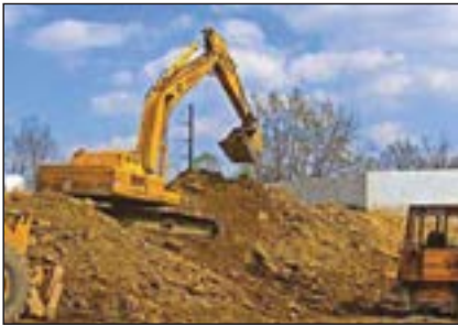
شکل ۱-۱۳- کندن زمین با وسایل مکانیکی
