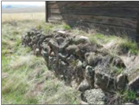
شکل ۱-۳۲ پی سنگی با سنگ لاشه
