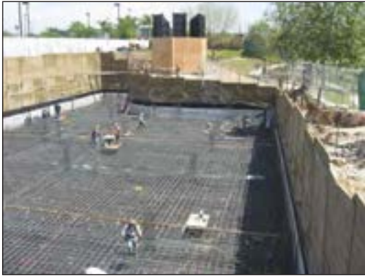
شکل ۱-۶۲ پی بتن مسلح یکپارچه (رادیه ژنرال)
