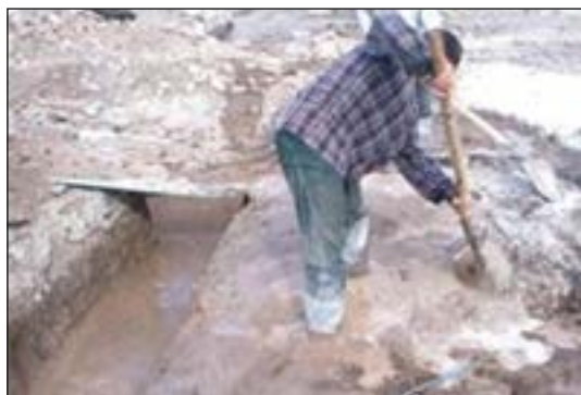
شکل ۱-۳۱ اجرای شفته آهک در فونداسیون
