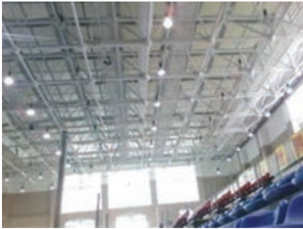
شکل ۱۶-۶- سقف باروکش فلزی
