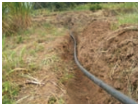
الف) لوله‌های نیمه اصلی داخل کانال حفر شده (ب) لوله‌های نیمه اصلی روی زمین
