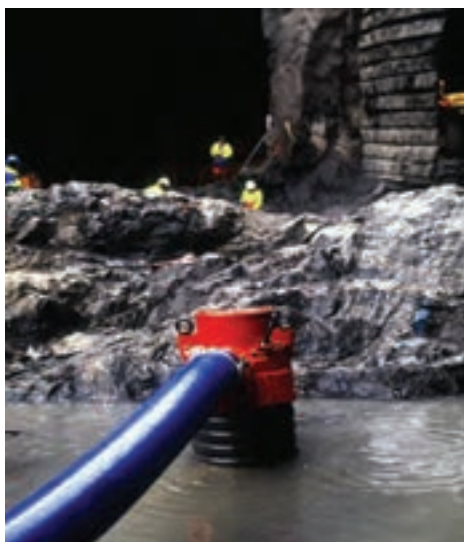
شکل ۱-۳- پمپ زهکش در حال کار
