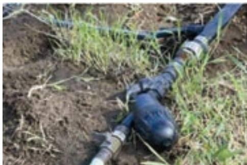
الف) فیلتر در مسیر شبکه آبیاری
