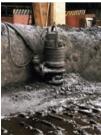
شکل ۹-۵- نصب پمپ کف کش در جاله
