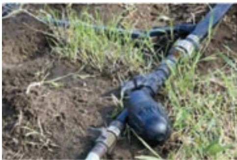
الف) فیلتر در مسیر شبکه آبیاری
