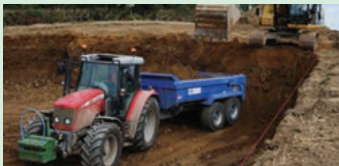
شکل ۲۱-۴- بارگیری نامناسب پی‌نورد
