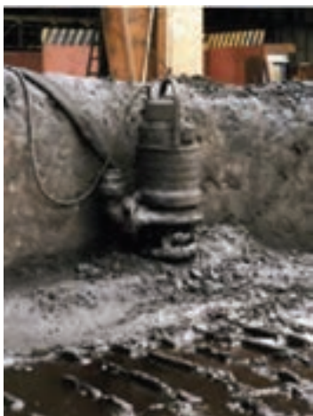
شکل ۹-۵- نصب پمپ کف کش در جاله
