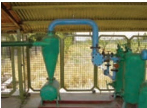
شکل ۲۷-۶- نحوه کار سیکلون و شکل ظاهری آن
