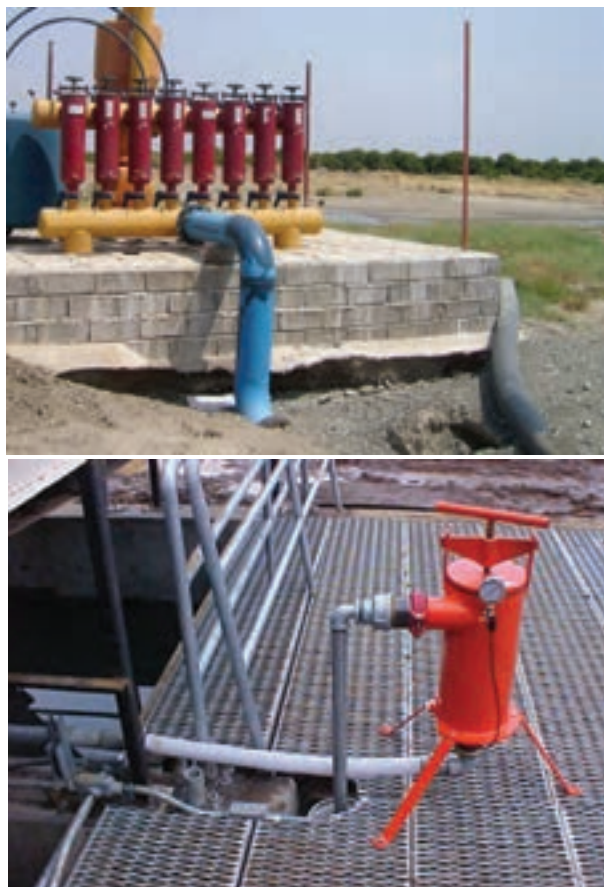
شکل ۲۶-۶- تأسیسات و تشکیلات یک فیلتر توری دار
