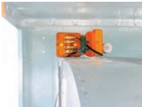
شکل ۱۲-۱۱- جعبه اتصال الکتریکی کولر
