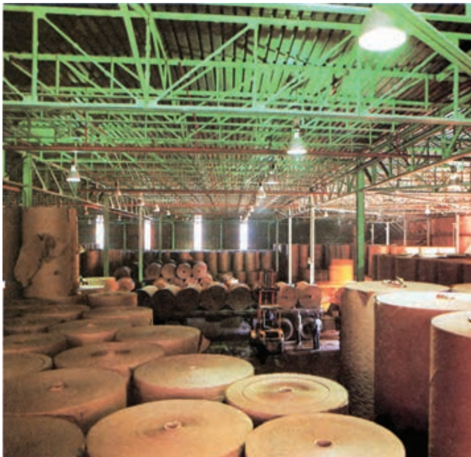
شکل ۱-۲- یک انبار سرپوشیده ویژه نگهداری مواد
