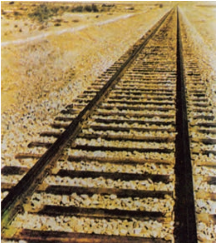
شکل ۱-۶- تراورس راه آهن اشباع‌شده با کروتوزوت
