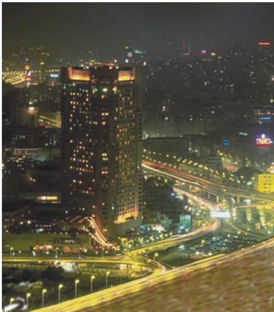
شکل ۱۰-۱- منظره‌ای از توزیع انرژی الکتریکی داخل شهر
