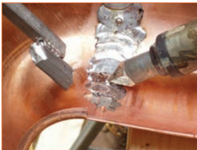
شکل ۲۲ - پرکردن درز اتصال به وسیله مذاب لحیم
