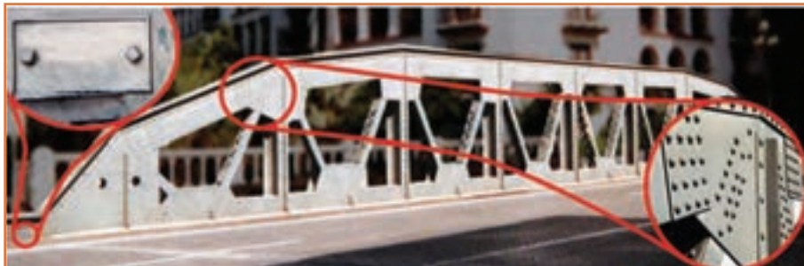
شکل ۳- اتصال دائم : پرچ
