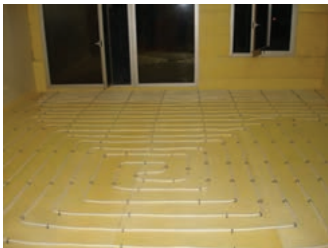
شکل ۱۸-۴- اجرای سیستم کف گرمایی در یک اتاق
