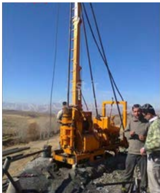
دستگاه حفاری مستقر شده بر روی فونداسیون
