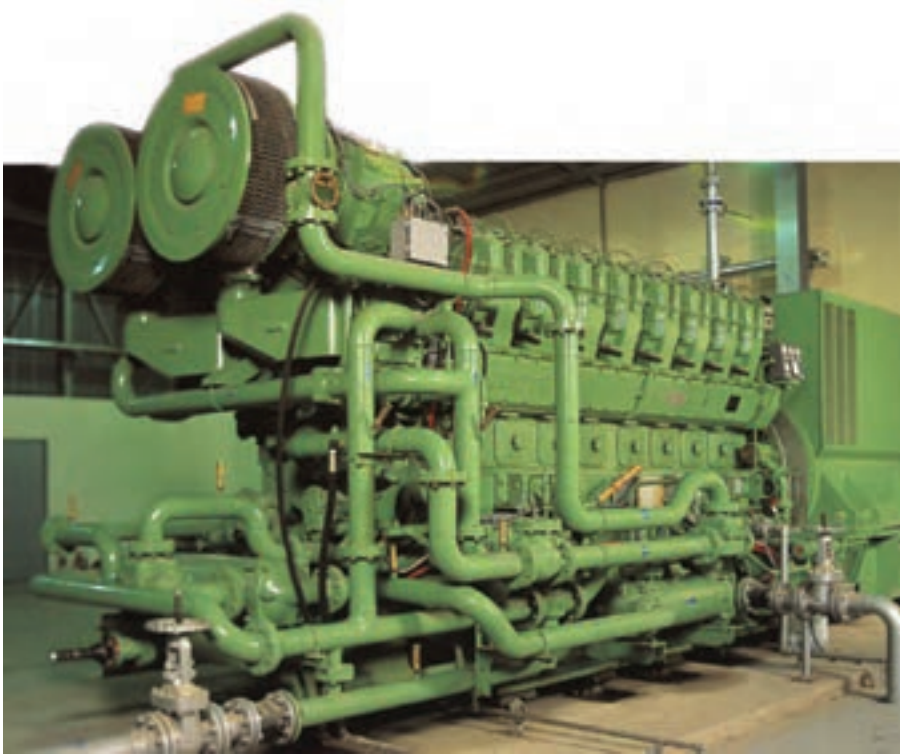
شکل ۲-۸- موتور ژنراتور یک نیروگاه برق اضطراری معدن
