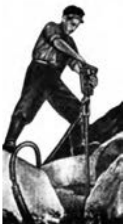
شکل ۴-۱۳- وضعیت ناپایدار کارگر کوه‌بر روی گرانیت (۶)
