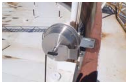
شکل ۴-۲۳ تخلیه الکتریسیته ساکن در مخزن سقف شناور
