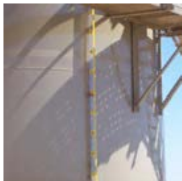
شکل ۱۹-۴ ارتفاع سنج مغناطیسی روی مخزن
