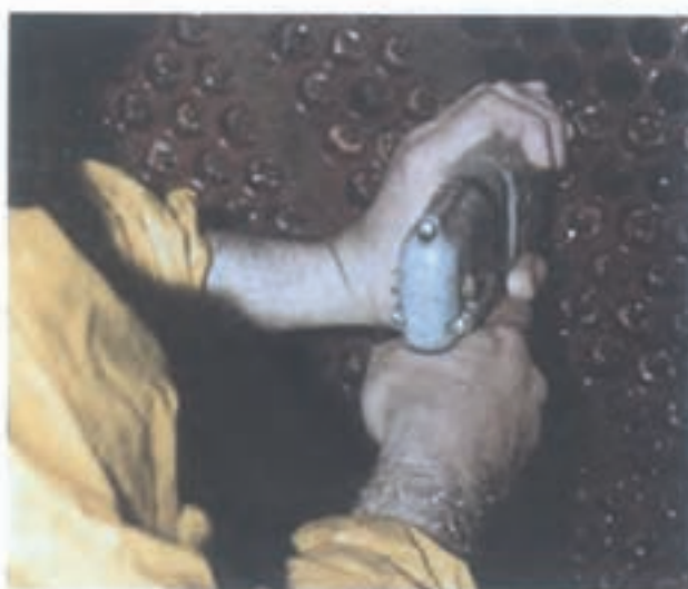
شکل ۱-۱۸- تمیز کردن تیوبهای کندانسور: استفاده از روش جت پراش
