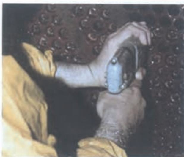
شکل ۱-۱۸- تمیز کردن تیوبهای کندانسور: استفاده از روش جت برای
