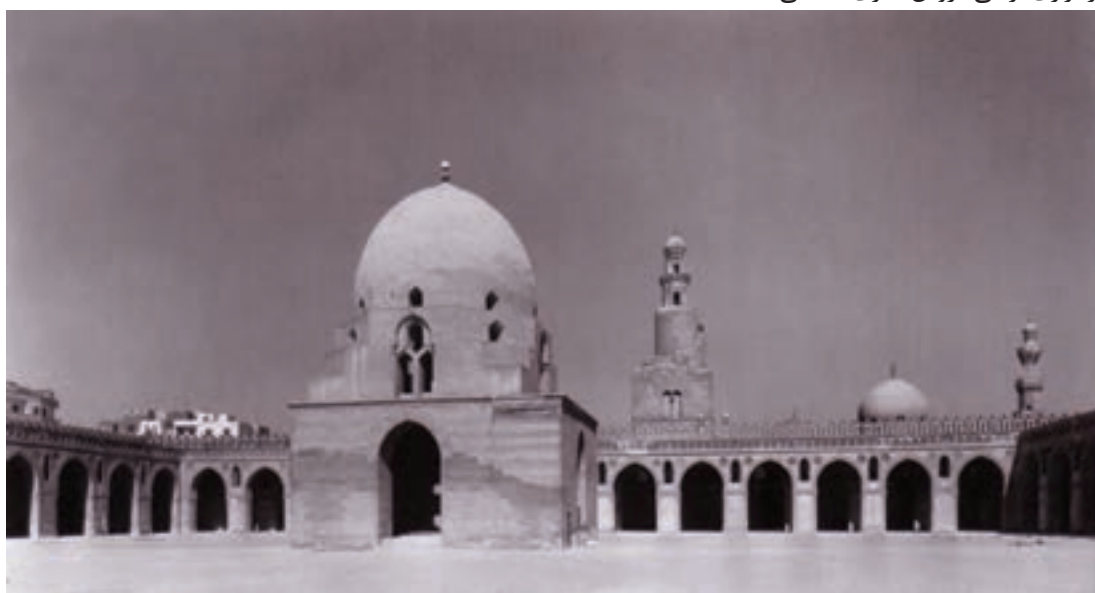
۱۰-۷- مسجد ابن طولون ، فسطاط ، نمای کلی ، ۲۶۶ هجری
