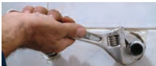
۵- سفت کردن دنباله‌ها با آچار فرانسه
