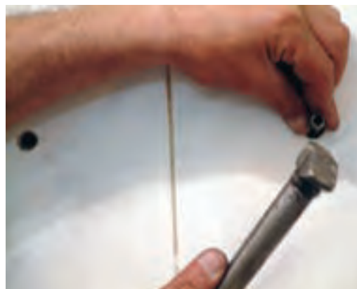
۳- کوبیدن رول پلاک در درون سوراخ‌ها
