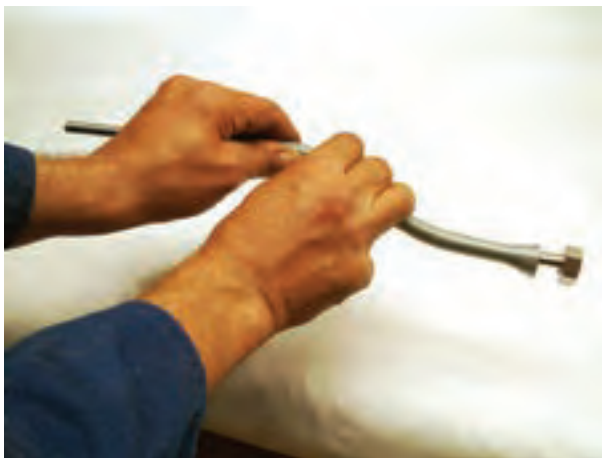
۱- خم زدن لوله پیسوار به وسیله فتر
