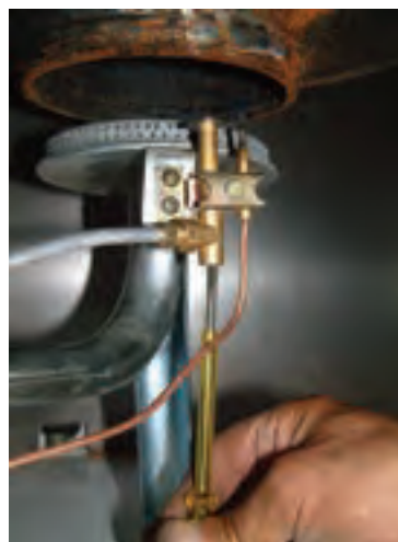
شکل ۶-۱ تنظیم شعله پیلوت
