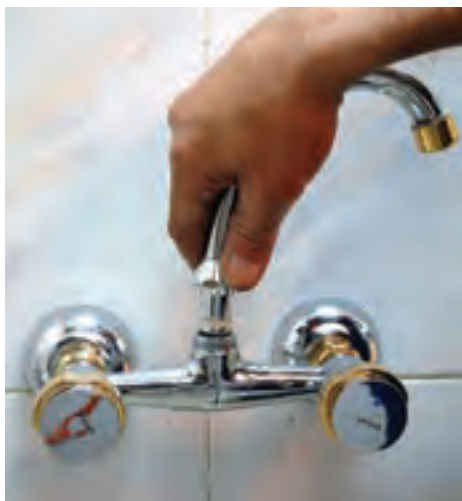
۱۳- جازدن غلم شیر مخلوط در درون نافی شیر
