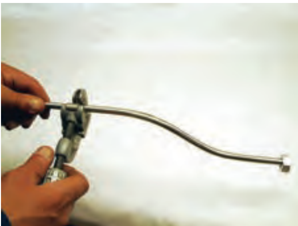
۲- بریدن لوله پیسوار به وسیله لوله‌بُر
