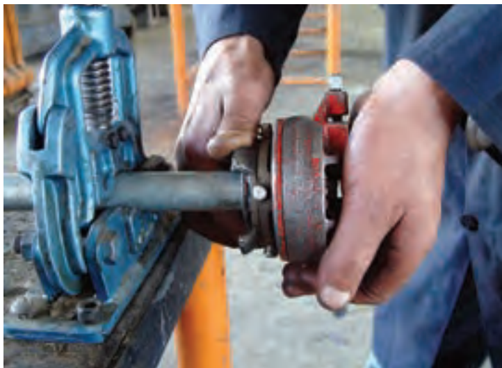
شکل ۱-۳۲- عبور حدیده از روی لوله و بستن چهار نظام
