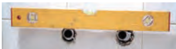
۷- سنجش صاف بودن دنباله‌ها به وسیله تراز
