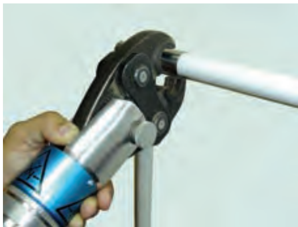
شکل ۱۱-۴- نحوه کار با دستگاه پرس
