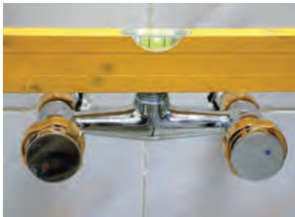
۱۲- سنجش تراز نصب شدن شیر مخلوط به وسیله تراز
