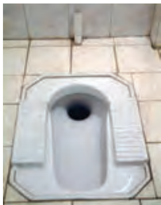
(ب) قرار دادن کاسه توالت بر روی سیفون شترگلو و فرش کردن کف توالت
