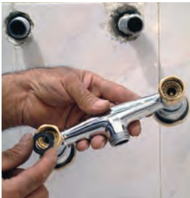
۹- قرار دادن واشرهای \frac{3}{4} در درون مهره‌های \frac{3}{4} تنه شیر
