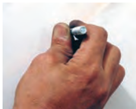
۴- قرار دادن پیچ روکا در درون رول پلاک
