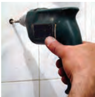
۲- سوراخ کردن محل پیچ‌های روکا
