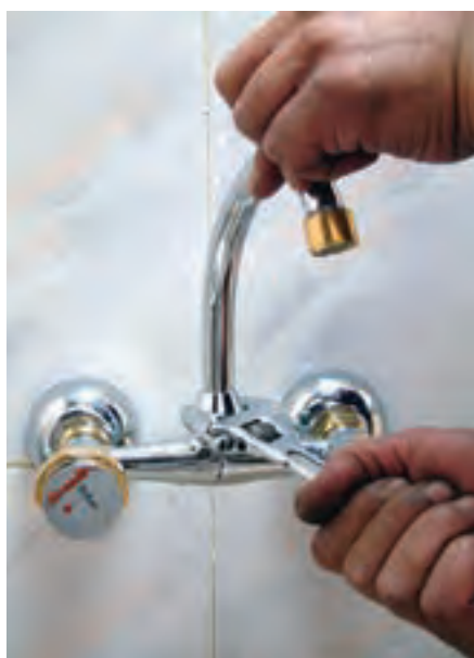
۱۵- سفت کردن مهره غلم شیر مخلوط به وسیله آچار فرانسه
