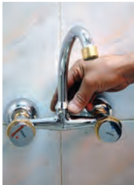
۱۴- سفت کردن مهره غلم شیر مخلوط به وسیله دست
