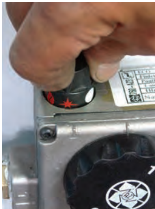
شکل ۷-۱۲- فشار شستی برای خروج گاز
