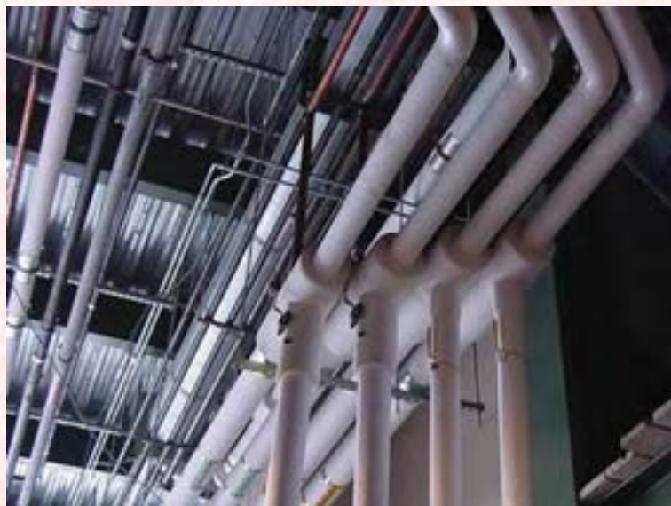
شکل ۳۵-۲- عایق کاری (گرمابندی) لوله‌ها
