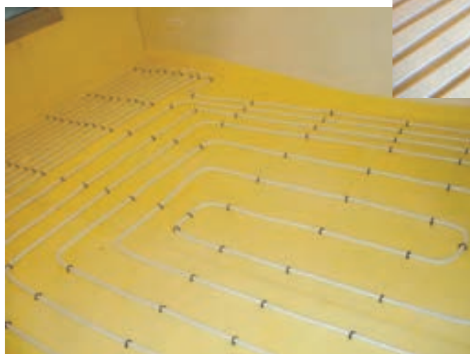
شکل ۳-۱۸- کف گرمایی اجرا شده
