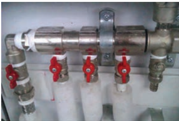
شکل ۱۹-۳- اتصال سرلوله‌ها به کلکتور
