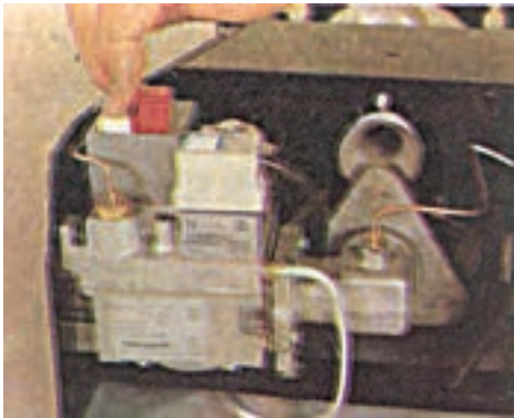
شکل ۷-۴- روشن کردن یک نوع مشعل
