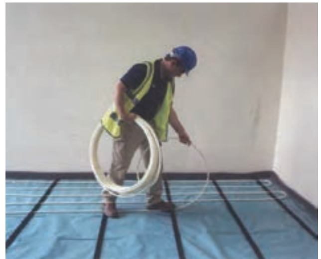
شکل ۹-۳- نمایش سیستم گرمایش از کف
