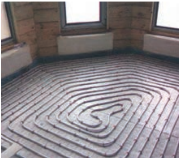
شکل ۹-۳- نمایش سیستم گرمایش از کف
