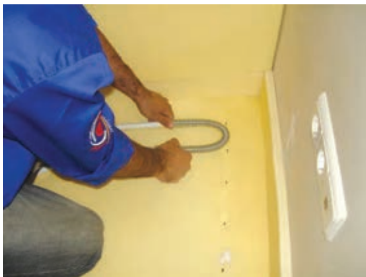
شکل ۳-۱۷- چگونگی خم کردن لوله
