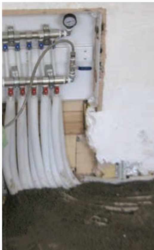
شکل ۳-۲۱- پوشاندن لوله ها
