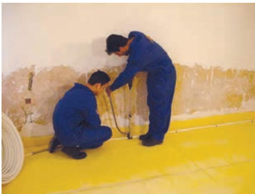
شکل ۳-۱۶- بست زدن لوله‌ها
