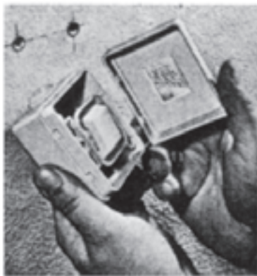
شکل ۳۲-۵- مراحل چگونگی نصب کلید روکار
