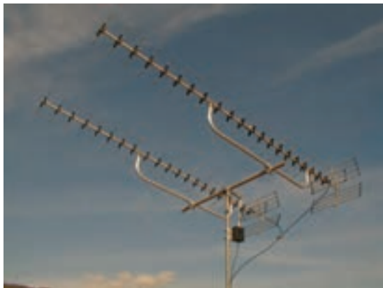
شکل ۷-۲۸- آنتن و لوله‌های آن
