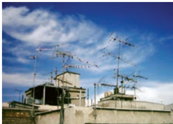
شکل ۷-۵ - یک مجتمع مسکونی با چندین آنتن در کنار هم
