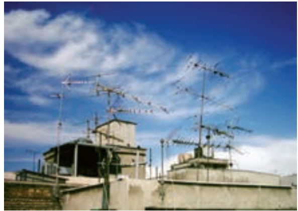
شکل ۲۹-۷ — یک مجتمع مسکونی با چندین آنتن در کنار هم
