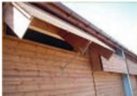
تصویر ۲-۱۴- انواع دریچه‌های ورود هوا
