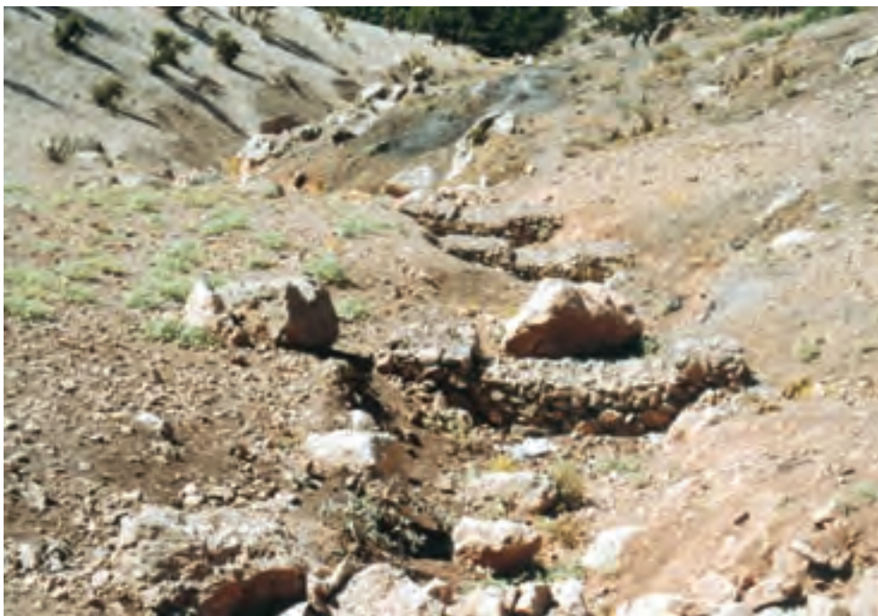
شکل ۳۹-۳ سدهای خشکه چین با تور سیمی در آبراهه‌ها
