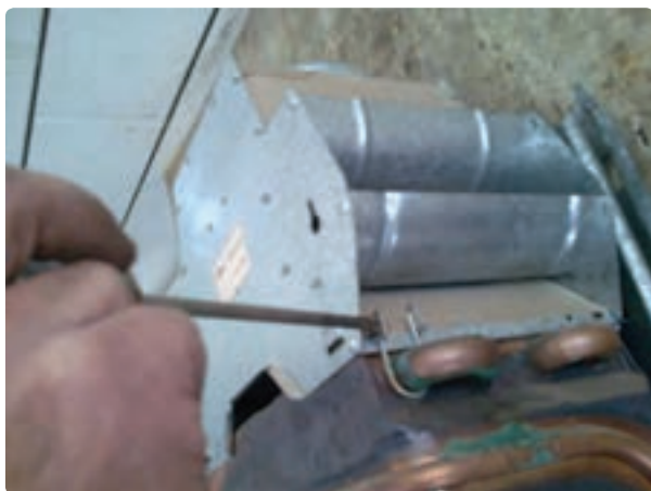
شکل ۶-۱- جدا کردن کلاhek تعدیل از مبدل
