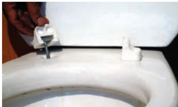
شکل ۲۵۳-۳- اتصال بست‌های نگهدارنده به توالت فرنگی
