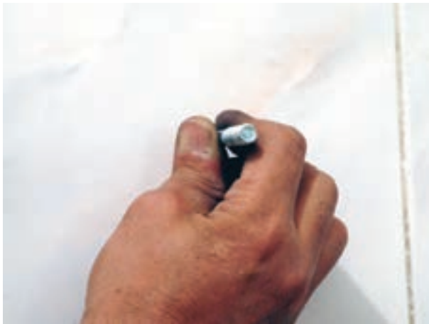
شکل ۳-۴۳- بستن پیچ‌ها در درون رولپلاک‌ها با دست
