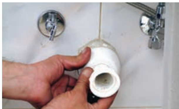
شکل ۳-۵۳ قرار دادن لوله افقی سیفون در درون لوله فاضلاب
