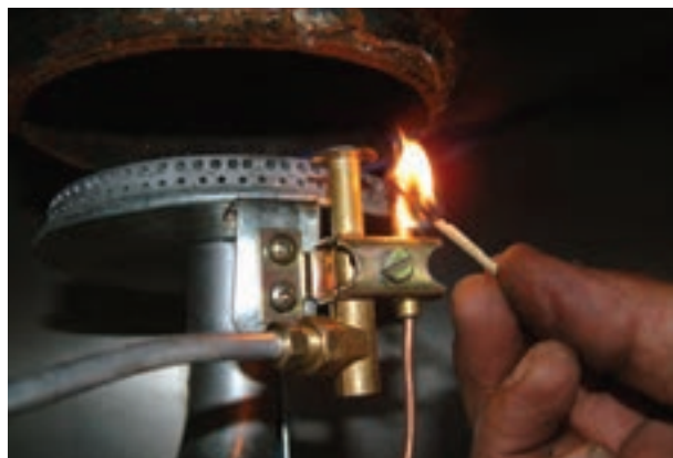
شکل ۱-۱۰۵ مشتعل کردن شمعک به وسیله‌ی شعله‌ی کبریت
