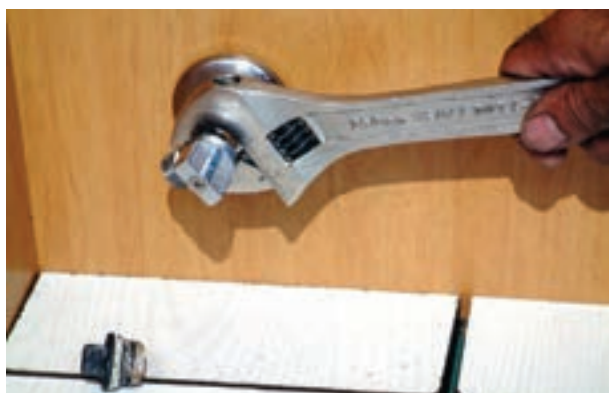
شکل ۲۵۴-۳- سفت کردن شیر پیسوار
