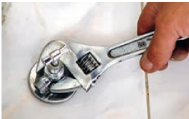
شکل ۲۲۰-۳- سفت کردن شیر پیسوار با آچار فرانسه
