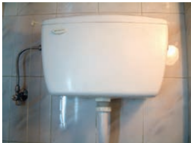
نصب مخزن فشاری
