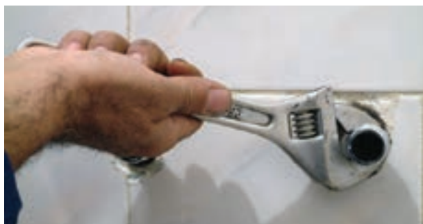
شکل ۱۶۷-۲- سفت کردن دنباله‌ها با آچارفرانسه
