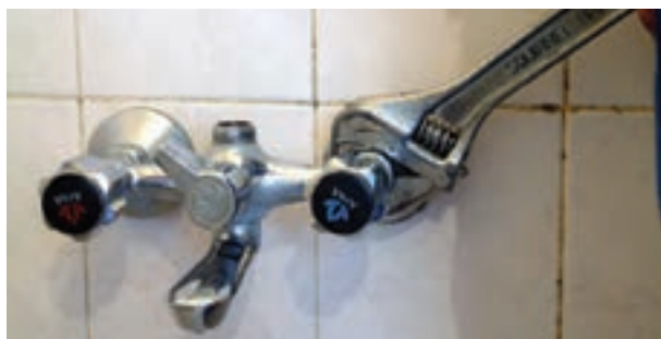
شکل ۲-۲۰۶ سفت کردن مهره‌های شیر با آچار
