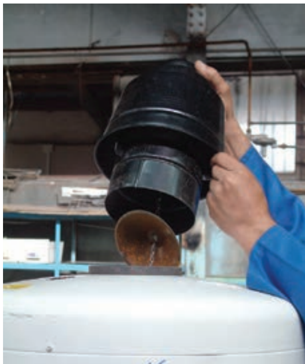
شکل ۱۱۵-۱ برداشتن کلاهک تعدیل از روی دودکش
