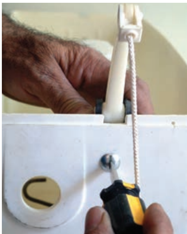
شکل ۳-۲۰۹- اتصال اهرم به بدنه‌ی مخزن فشاری
