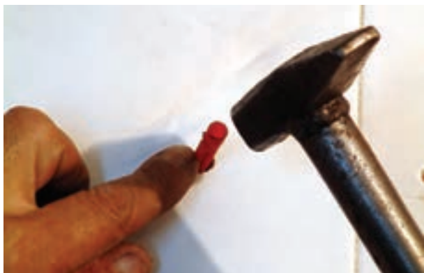
شکل ۱۹۳-۲- کوبیدن رولپلاک درون سوراخ
