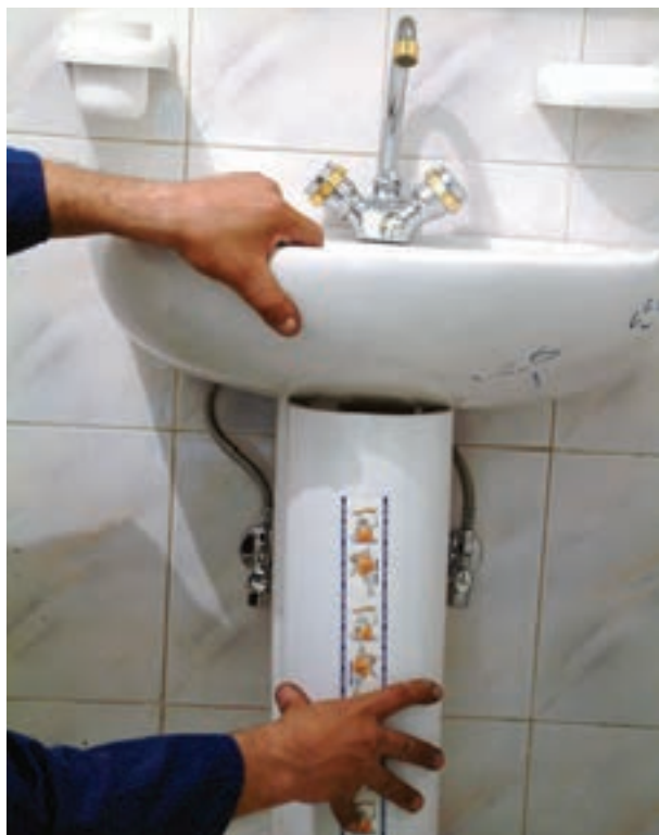
شکل ۳-۵۸- قرار دادن پایه‌ی دست‌شویی در زیر آن
