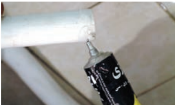
شکل ۳-۲۰۵- زدن چسب به لوله‌های تخلیه
