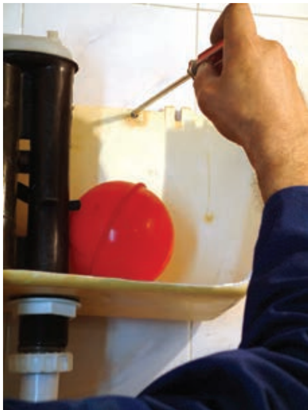
شکل ۲۱۳-۳ نصب مخزن فشاری به دیوار
