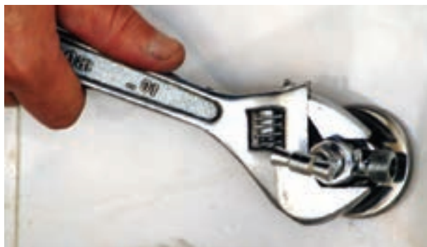
شکل ۱۴۴-۲- سفت کردن شیر پیسوار با آچار فرانسه
