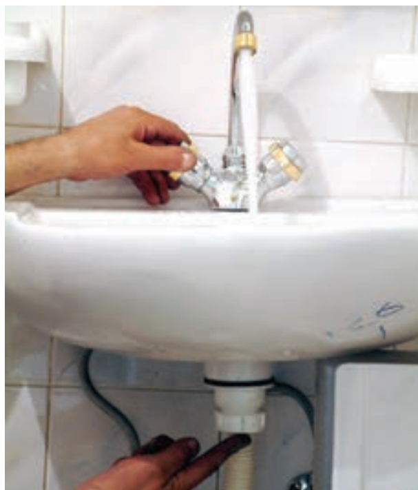
شکل ۳-۵۷ عمل کنترل نشت آب از محل‌های اتصال
