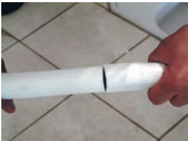
شکل ۳-۲۰۶- جا زدن لوله‌های تخلیه در درون یکدیگر
