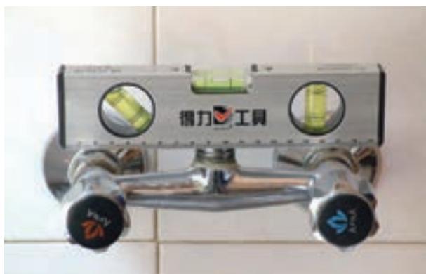
شکل ۱۷۴-۲ سنجش تراز بودن شیر مخلوط دیواری
