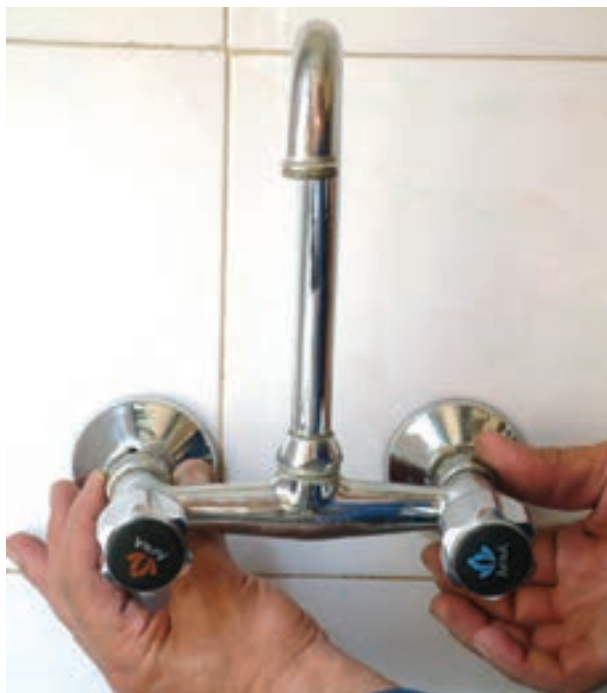
شکل ۱۷۲-۲ پیچیدن مهره‌ها به دنباله‌های شیر مخلوط
