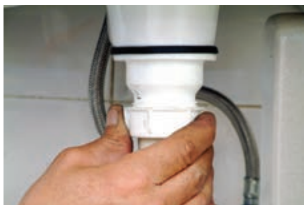
شکل ۳-۵۶ بستن مهره‌ی لوله‌ی عمودی سیفون به زیراب
