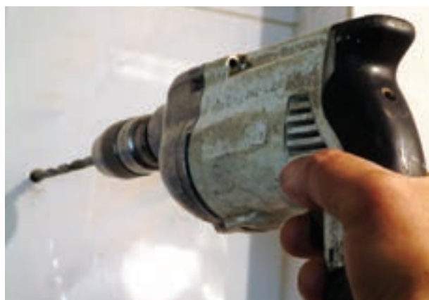
شکل ۲-۱۹۲- سوراخ کردن محل نصب بست آویز
