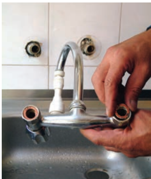
شکل ۱۷۱-۲- قراردادن واشر درون مهره‌ی تنه شیر مخلوط
