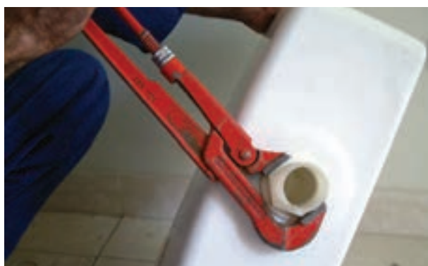
شکل ۳-۲۰۸- سفت کردن مهره‌ی پمپ تخلیه
