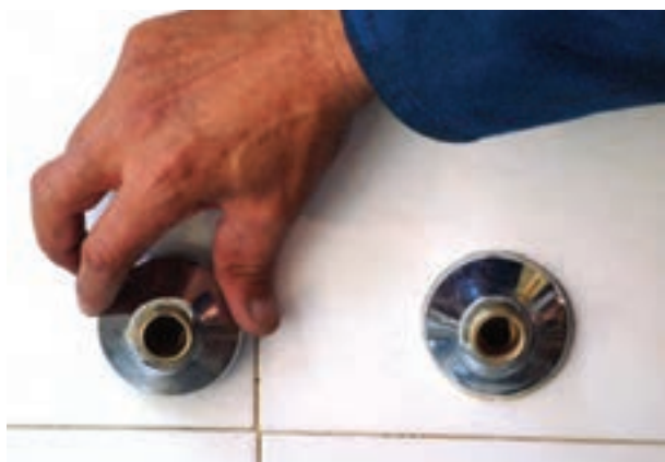
شکل ۱۷۰-۲- بستن کاسه‌ها به دنباله‌ها با دست
