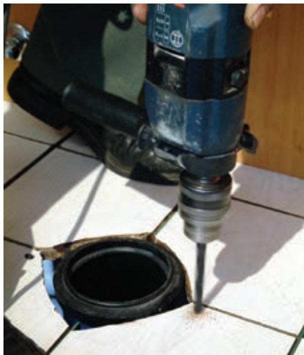
شکل ۲۴۶-۳- سوراخ‌کاری محل‌های علامت‌گذاری شده
