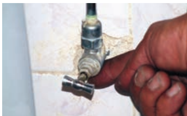
شکل ۱۴۷-۲- کنترل نشت آب از محل اتصال
