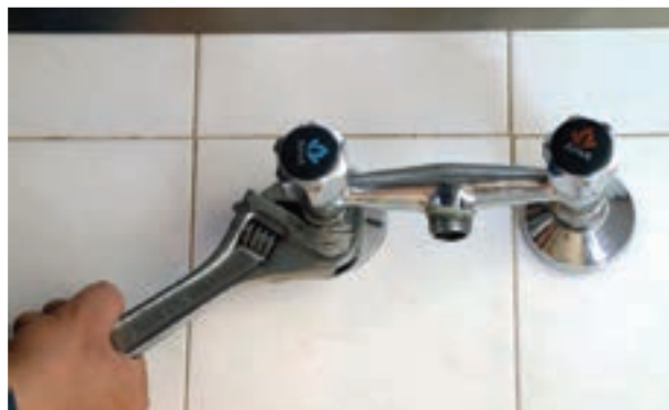
شکل ۲-۱۸۹- سفت کردن مهره‌ها با آچار فرانسه
