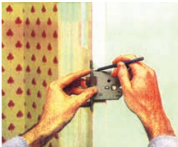
شکل ۱۰-۴۴ - فم‌کشی محل قفل (روی نر کار).
