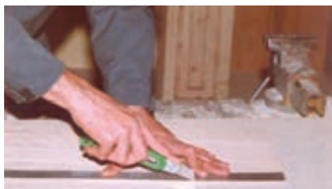
شکل ۵-۲۹- برش (روکش با کاتر)
