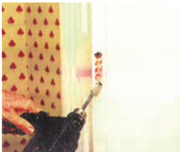
شکل ۱۰-۴۵ - تفلیه‌ی محل قفل با دریل.
