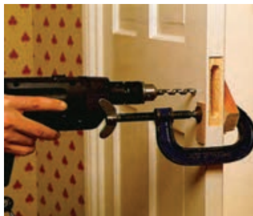
شکل ۱۰-۴۸- سوراخ‌کاری ممل پلاک و دستگیره‌ی قفل.
