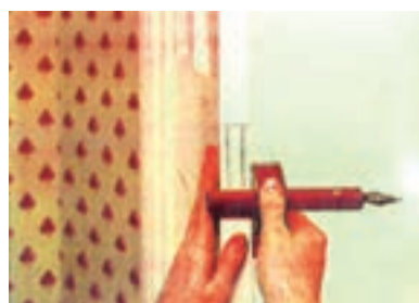
شکل ۱۰-۴۳ - فم‌کشی محل قفل با فم‌کش تیره‌دار.
