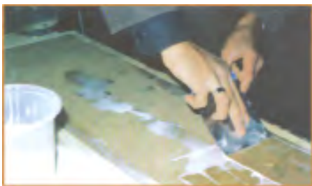
شکل ۵-۳۲- نمونه‌ی پخش کردن چسب به وسیله‌ی کاردک.
