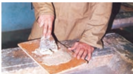
شکل ۴-۹- بتونه روی تخته بتونه تهیه و سافته می شود.
