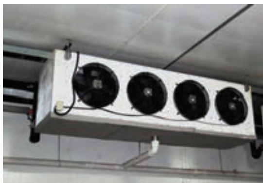
شکل ۶-۳- اواپراتور با جریان هوای اجباری
