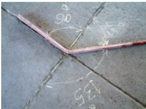
شکل ۳-۲۹- کنترل خم لوله‌های ۴۵ درجه
