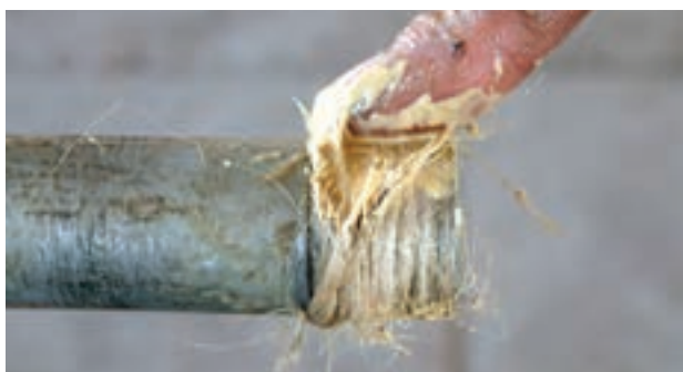
شکل ۵-۵۷- مالیدن خمیر آب بندی بر روی کنف
