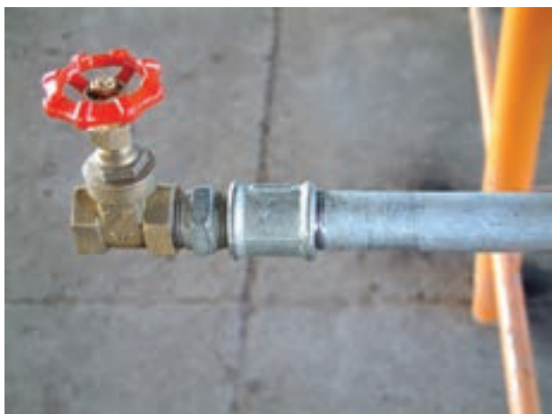
شکل ۴-۸- اتصال دنده‌ای
