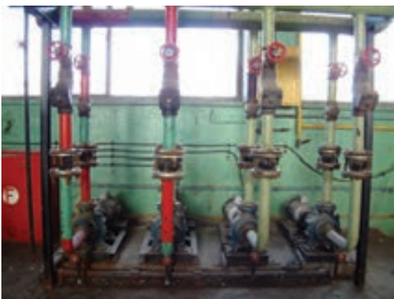
شکل ۵-۳- کاربرد لوله درزدار در لوله‌کشی شوفاز
