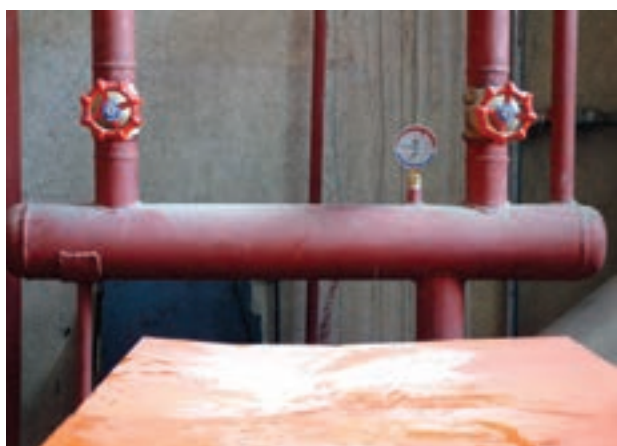
شکل ۳۲-۵- استفاده از اتصال جوشی در حرارت مرکزی
