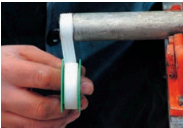
شکل ۵-۵۸- نحوه پیچیدن نوار تفلون بر روی سردنده
