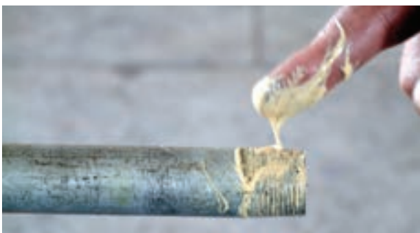
شکل ۵-۵۳- مالیدن خمیر بر روی سردنده
