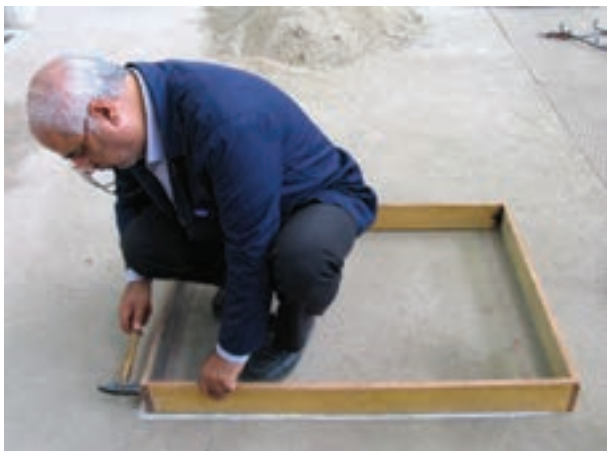
شکل ۳-۱- قالب‌بندی فونداسیون
