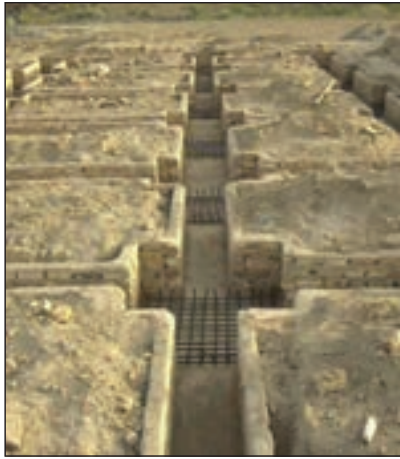
شکل ۳-۵۴ آرماتورگذاری پی تکی کلاف بندی شده
