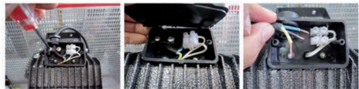
شکل ۲-۲۵ - سیم کشی در جعبه اتصالات
