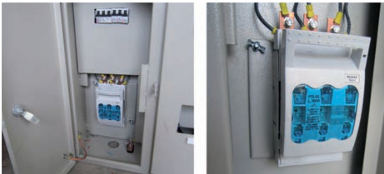
شکل ۲۳-۳- محل ورود کابل اصلی به داخل تابلو
