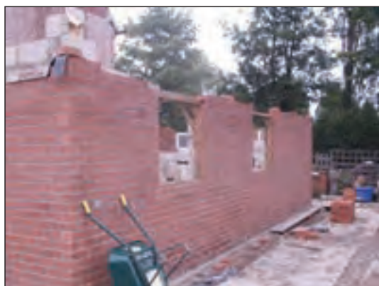
شکل ۱-۱۰۷ دیوار باربر آجری
