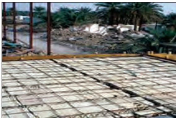
شکل ۱۳-۱ سقف تیرچه بلوک
