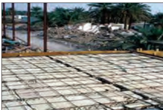
شکل ۱۳-۱ سقف تیرچه بلوک
