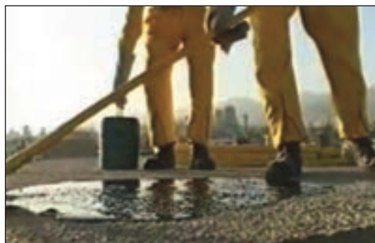
شکل ۲۲-۶ قیرگونی پس از پرکردن بین کُرْم‌ها
