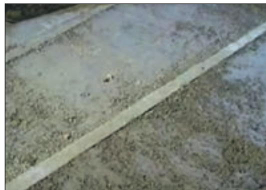
شکل ۲۱-۶ پرکردن فضای بین کرم‌ها با پوکه معدنی
