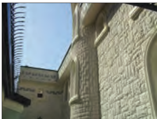
شکل ۱۳۱-۱ دیوار با مصالح سنگ بادبُر
