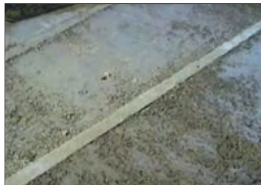
شکل ۲۱-۶ پرکردن فضای بین کرم‌ها با پوکه معدنی
